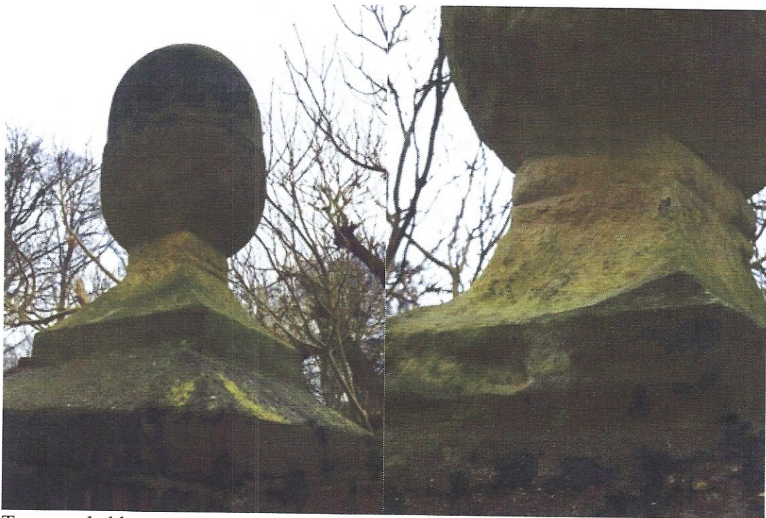
Toegangshekken met ornamenten.
